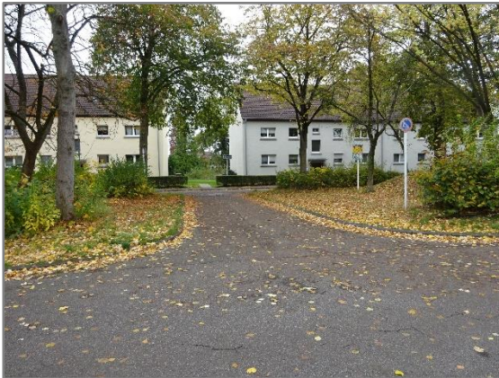
Abbildung 7 und 8: Querspangen zwischen den Richtungsfahrbahnen
