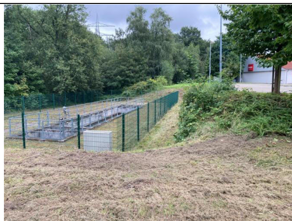
Foto 9: Regenrückhaltebecken am Nordrand des Bebauungsplangebietes östlich der Zechenstra- ße
