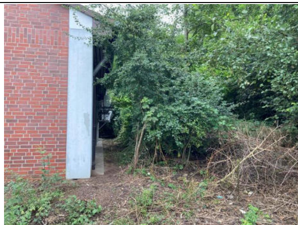
Foto 8: Gehölzbestandene Böschung am Hal- denfuß am Westrand des Geltungsbereichs
