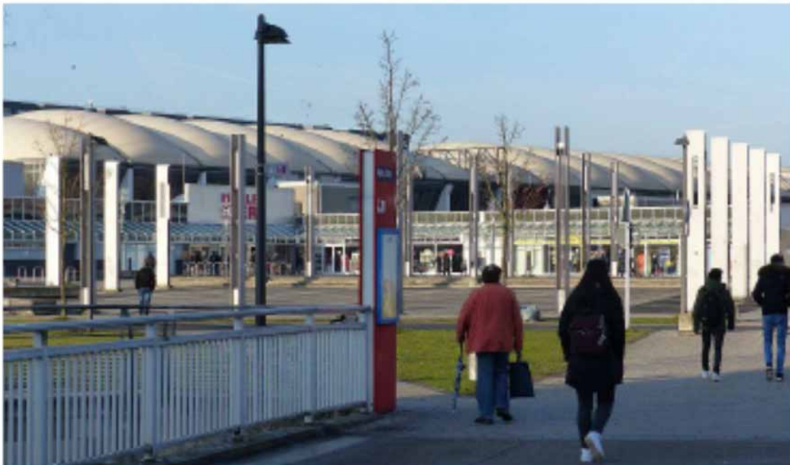
Blick von der Brücke über dem Bahnhof Marl-Mitte in Richtung Marler Stern.
