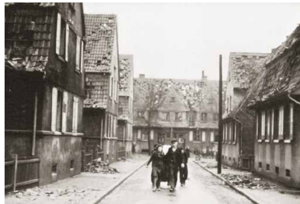
Die Siedlung »Im Beisen« nach einem Bombenangriff 1945. Gut zu erkennen: Viele Dächer wurden durch Detonationswellen teilweise abgedeckt, Schutt und kaputte Dachziegel liegen auf dem Gehsteig.
