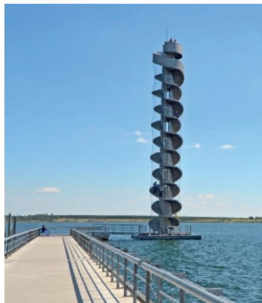
Im nördlichen Teil des Großen Goitzschesees, der aus dem ehemaligen Braunkohletagebau Goitzsche (sprich: Gottsche) hervorgegangen ist, steht der Pegelturm. Sein Name leitet sich von der Turmkonstruktion ab: Er schwimmt auf der Wasseroberfläche.
