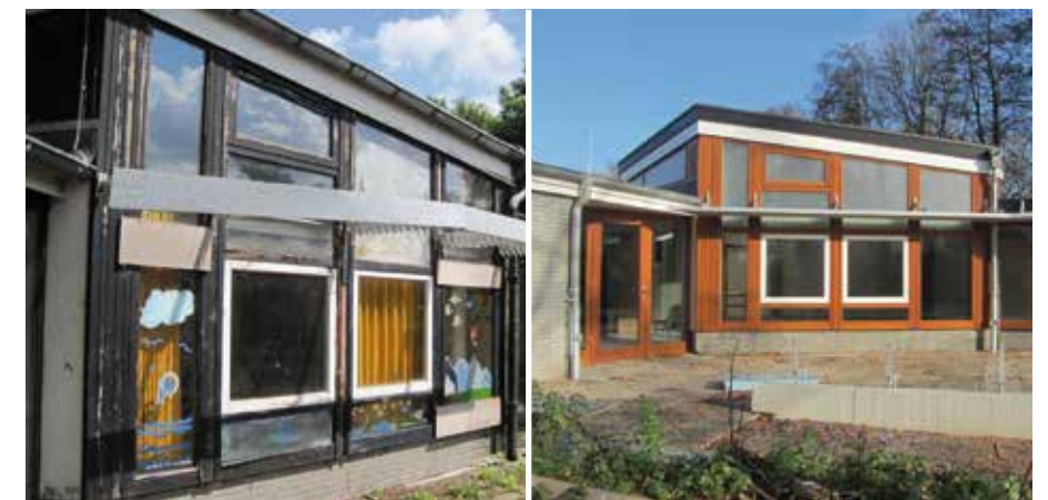
Die Außenfassade einer „Schulwohnung“ vor und nach der Sanierung.
