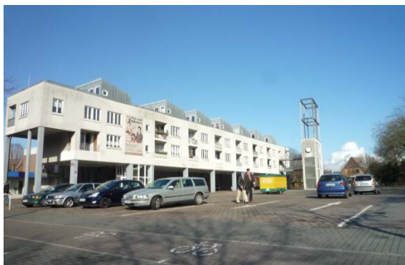
Abbildung 29: Wochenmarktgelände in Brassert
