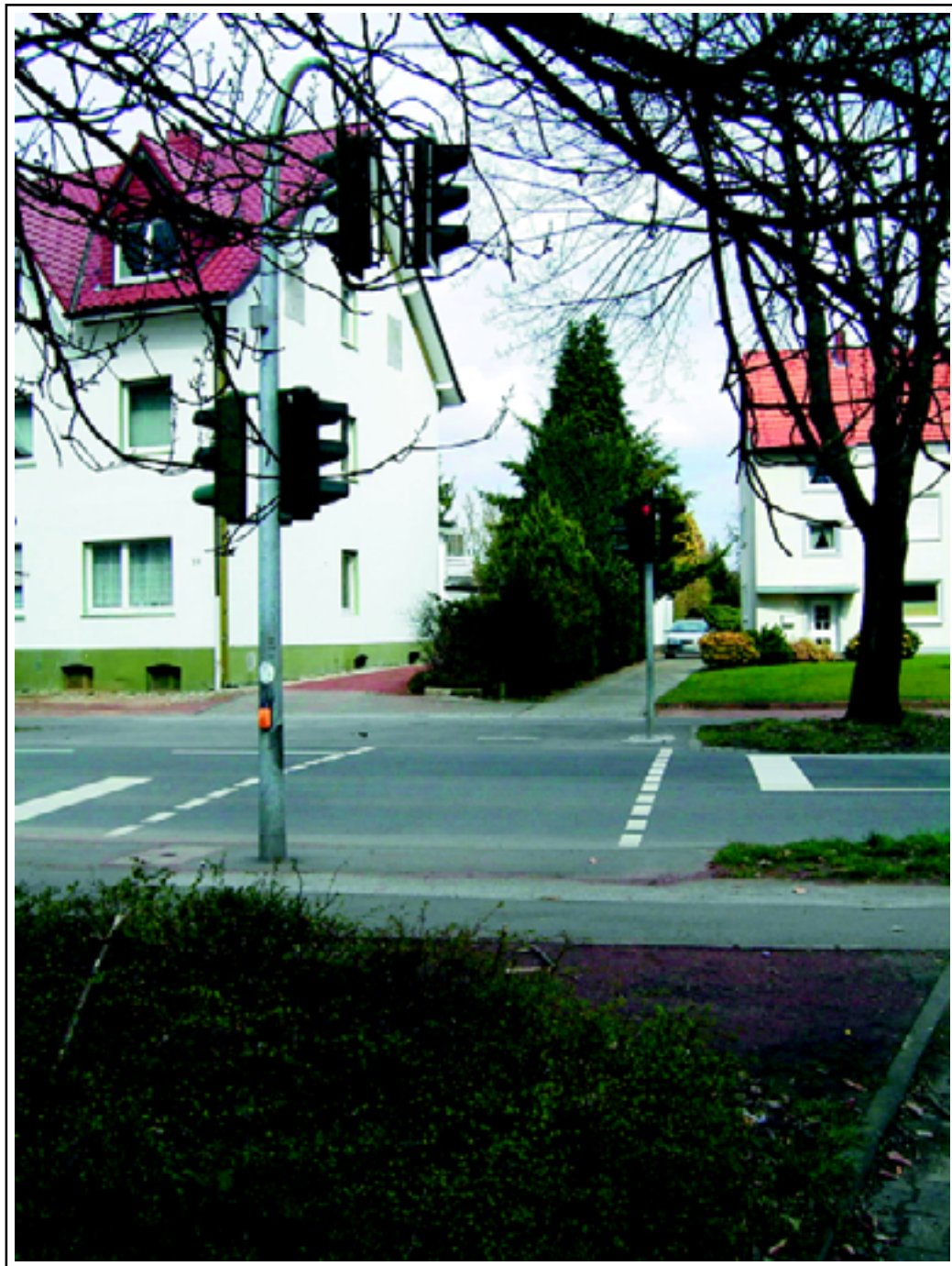
So sah die Ampel LZA 32 „Schulstraße/Haardschule“ vorher aus, eben wie eine ganz normale Fußgängerampel !
