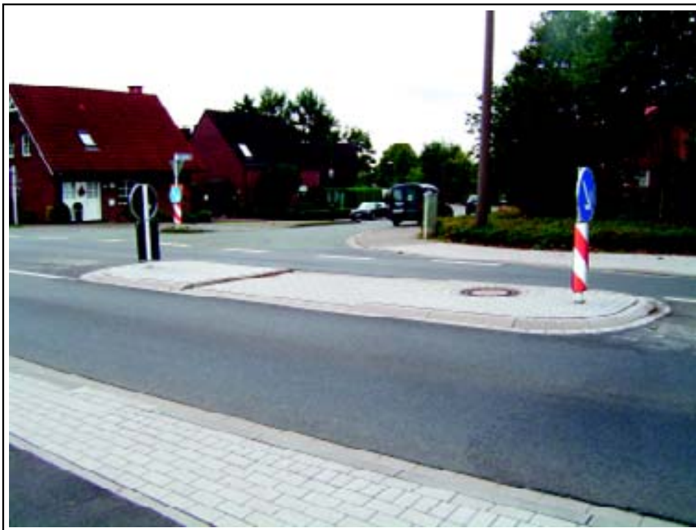
Neuer Fahrbahnteiler an der Schulstraße/Einmündung In de Flaslänne
