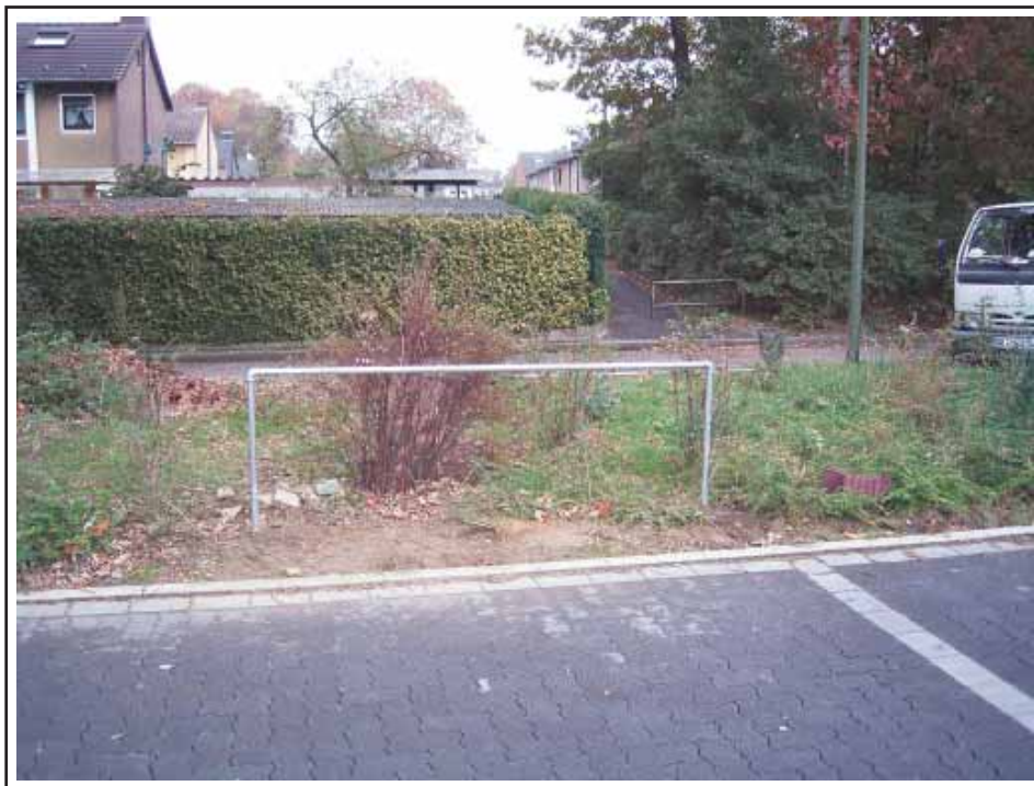
Ansicht vom Rebhuhnweg (Blick Richtung Nord-Osten). Die Anwohner haben wohl schon zur Selbsthilfe gegriffen und eine provisorische Sperre aus verzinktem Wasserleitungsrohr errichtet.
